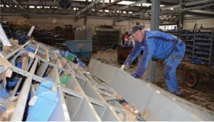
Stellenweise stand das Wasser vier Meter hoch. Mauern - wie an der Halle der Werksfeuerwehr - wurden weggerissen, tonnenschwere Maschinen verschoben, viele Maschinen und die so wichtigen Elektroschränke wurden teilweise oder komplett überflutet. Und überall Schlamm und Schutt. Die Weserbrücke auf dem Firmengelände, die recht hoch über den Flusslauf führt, wurde nochmals um einige Meter überspült. Jetzt plätschert dort ein kleines Rinnsal. Kaum zu glauben, aber bittere Realität.
