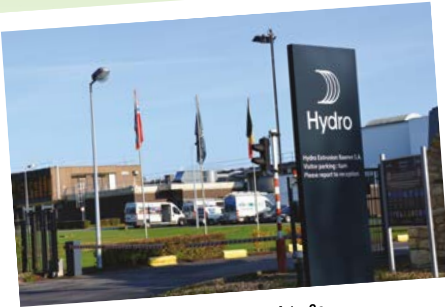
Das Hydro-Werk an der Raerener Waldstraße.
